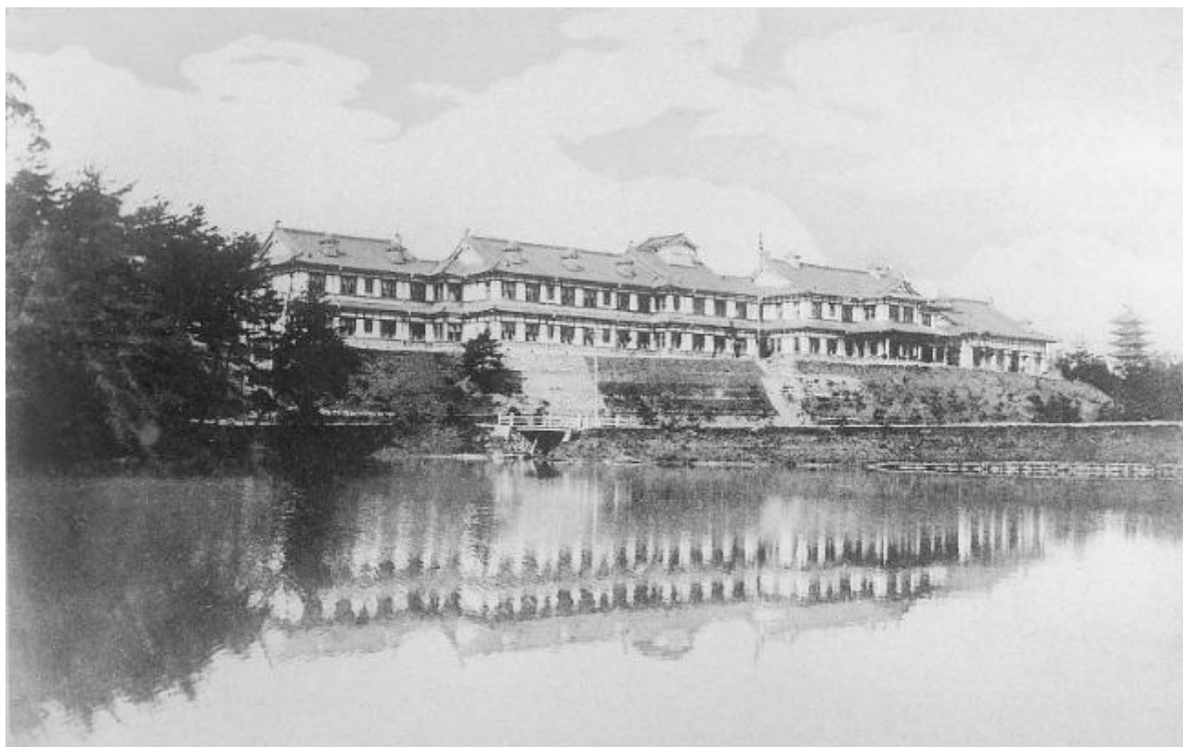
（建設中のホテル全景）
